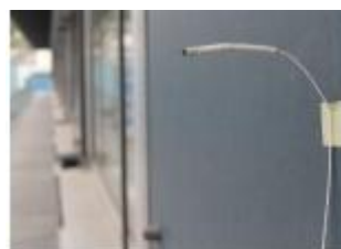
Εικόνα 17 - Εξωτερικός αισθητήρας θερμοκρασίας
